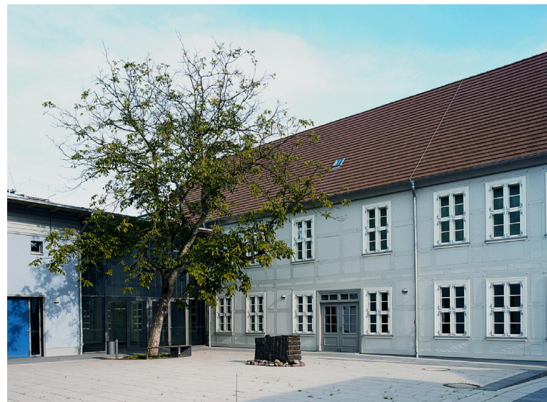
Innenhof der Kunstsammlung Neubrandenburg: Blick auf den Verbindungstrakt zum Neubau und das sanierte Ausstellungsgebäude mit rückwärtigem Eingang, 2004
